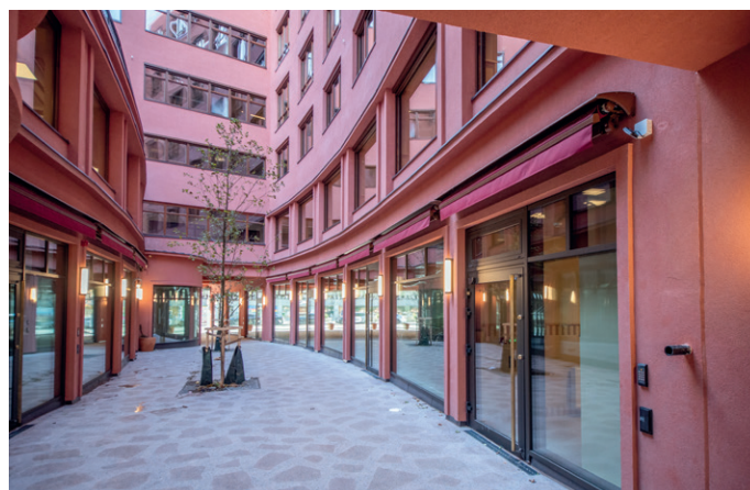
Den gamle fasadekledningen i rød granitt er knust og gjenbrukt i bakken i midten av fasaden.
