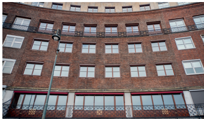
De historiske fasadene er etterisolert på innsiden, og vinduene er byttet ut i tråd med Byantikvarens innspill.
