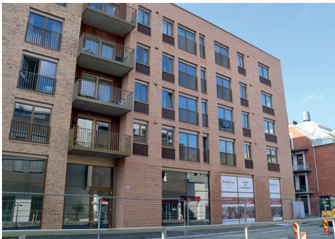
Ut mot hovedveien langs jernbanelinja er Fredheimkvartalet fem etasjer høyt.
