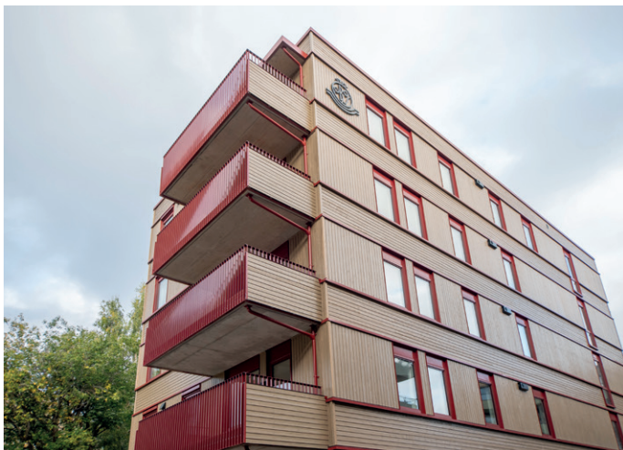
Ensjøkroken har plassbygde balkonger og plassbygde klimavegger.
