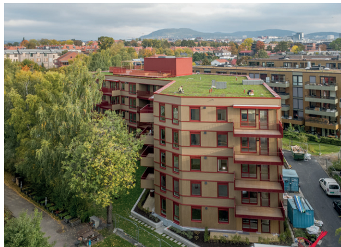
Røde beslag, rekkverk og vinduskarmer gir et friskt fargespill.
