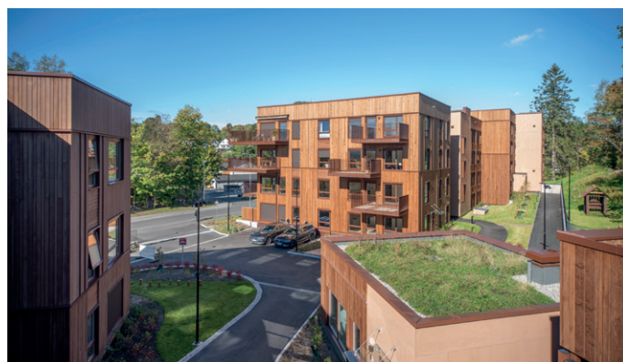
De trekledde fasadene brytes opp med sementbaserte fasadeplater på enkelte flater.
