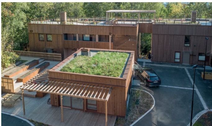
På tunet mellom boligene står et 60 kvadratmeter stort felles lysthus.
