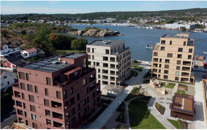
Byggene er omkranset av et beplantet uteområde.
