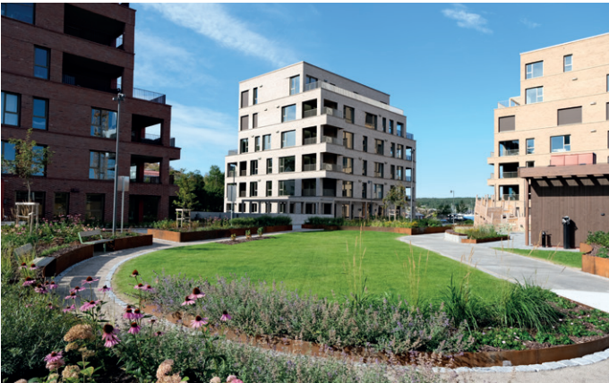
Første byggetrinn i prosjektet Innseilingen består av tre bygg.
