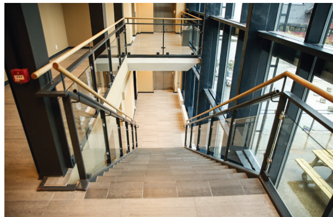
Trappeområdet mellom 2.- og 3.-etasje har gjenbrukte fliser.
