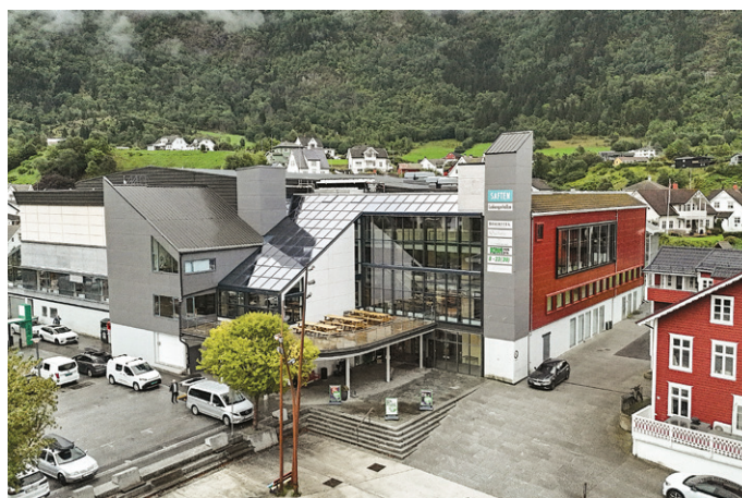
Saften-bygget midt i Hermansverk sentrum har vært gjennom mange utbyggings- og rehabiliteringsprosjekter.
