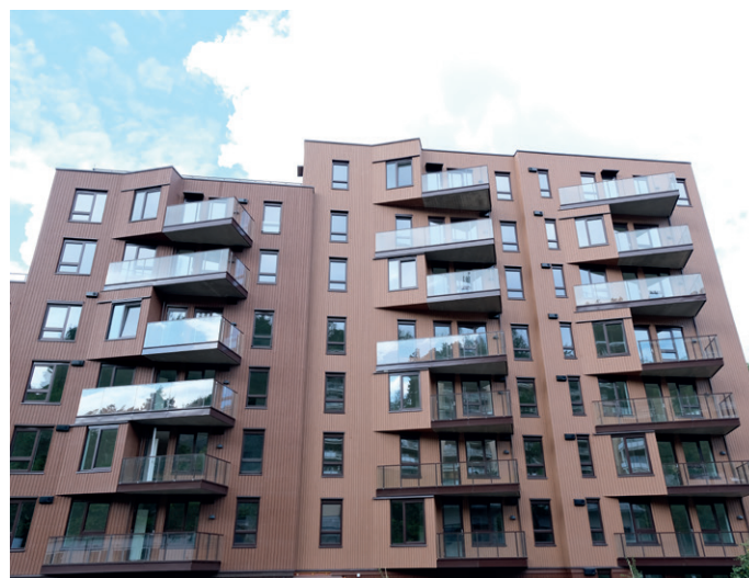
Kledningen er i all hovedsak panel.
