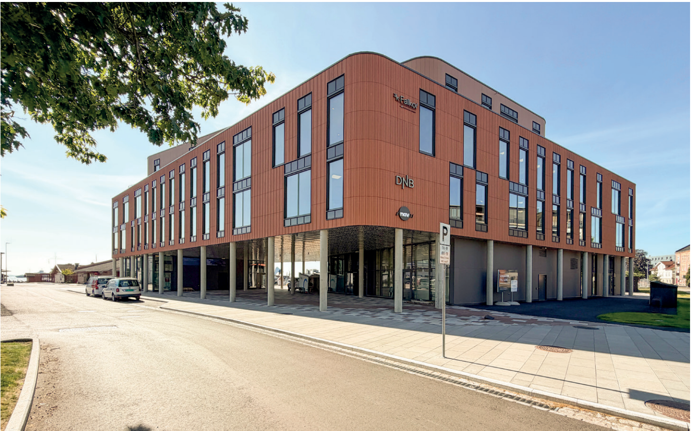
Bygget hviler på to bygningsbein med en portal mellom dem.
