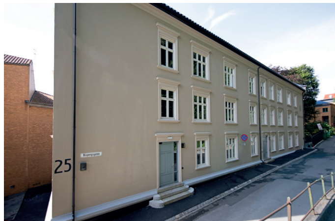
Fasade har grågul puss og vinduer som likner de som opprinnelig var i bygget.
