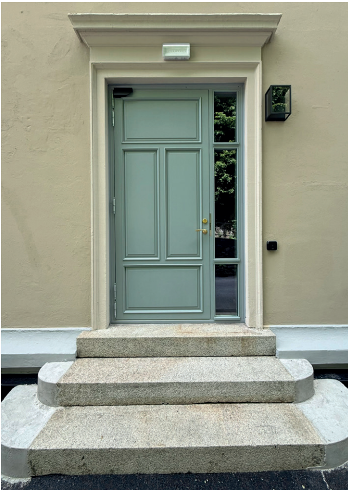
En av byggets to hoveddører.
