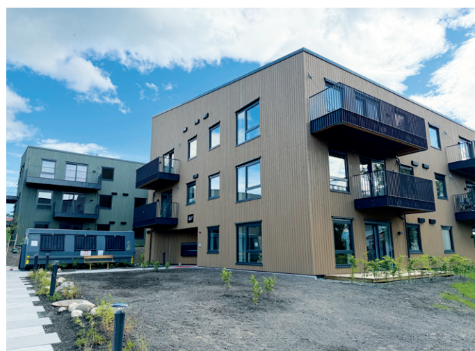
De fem blokkene består av tre og fire etasjer.
