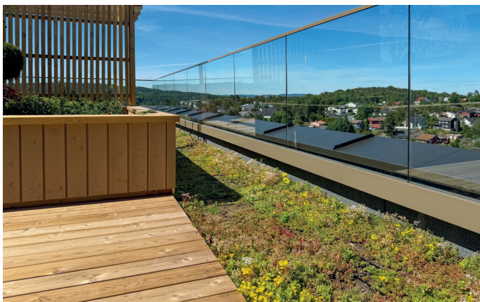
På takterrassen er det utstrakt bruk av sedumplanter.
