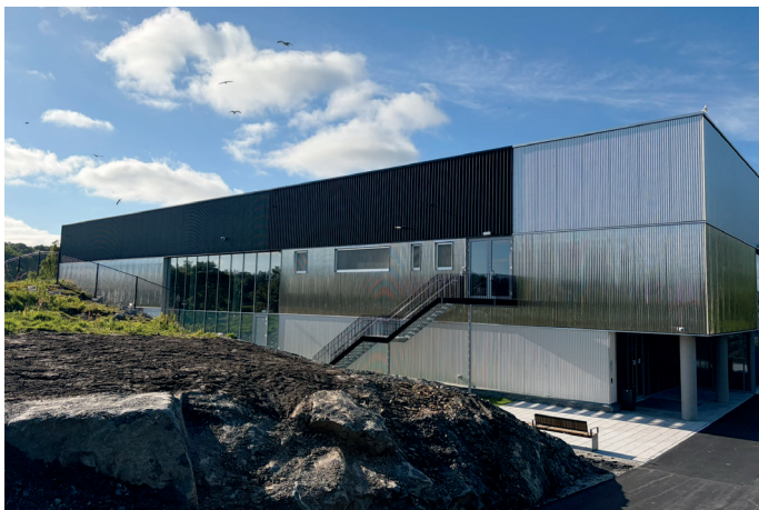
Klimaskallet består av påforingsvegger i tre og store glassfasader i aluminium med trelags glass. Foto: Jærentreprenør
