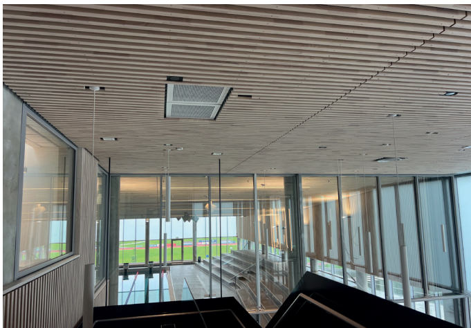
Innvendige tak og vegger preges av spiler, og mye innsats ble lagt ned for å plassere tekniske installasjoner riktig i forhold til spilene i himlingen.
