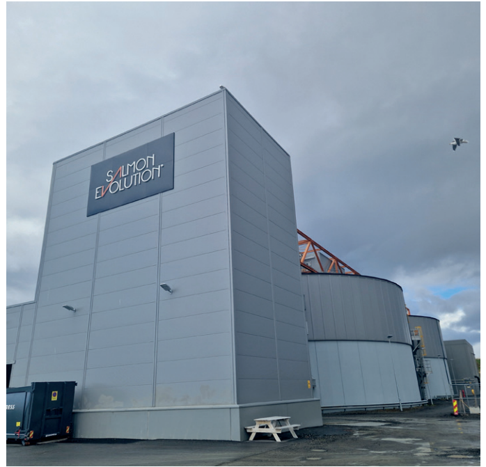
Salmon Evolution ruver i terrenget. Nærmest byggetrinn 1, byggetrinn 2 bakerst.
