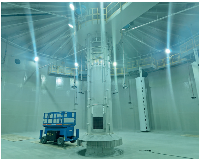
Inne i en av tankene som skal fylles med vann opp til gangveiene.
