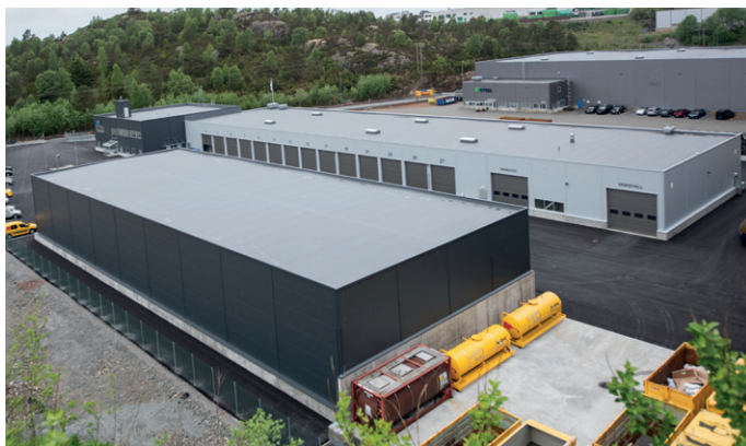
Norba24 Birkelands bygg ligger i Straume Næringspark i Øygarden kommune.
