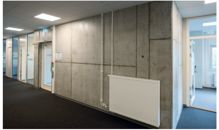
Filagt betong i kontordelen.
