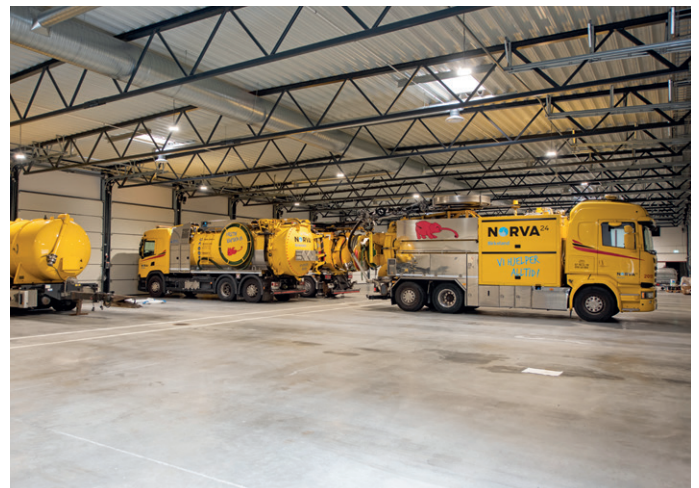
Bilhall med stålglattet betonggulv.
