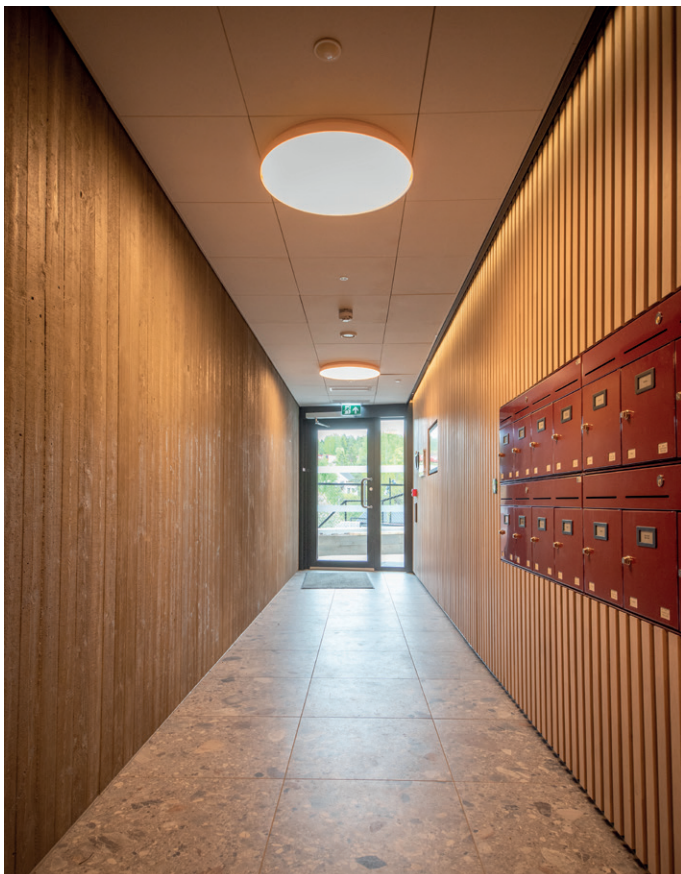
Terrazzofliser på gulvet og vegger med eksponert bordforsalet betong og trespiler viser frem noen av kvalitetene i prosjektet.
