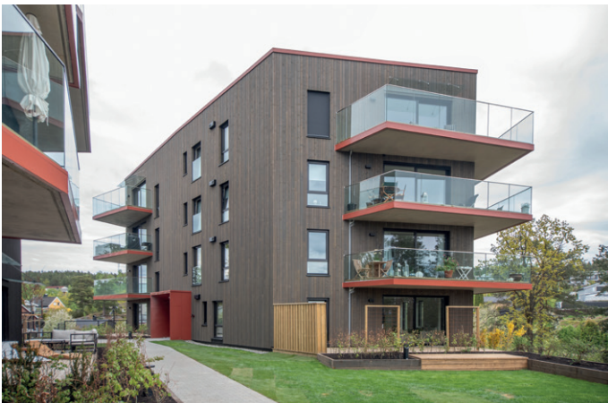
Byggene er kledd i trykkimpregner Tyr-kledning.
