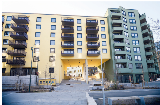
Mesteparten av bygningsmassen har åtte etasjer, men dette brytes opp med noen høyere bygg og en stor portal gjennom det ene bygget.
