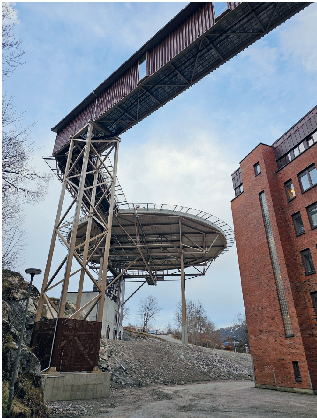
Totalt har Overhalla Mekaniske levert 132 tonn med stålkonstruksjoner til prosjektet.
