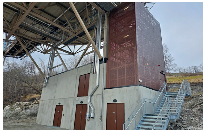
Et teknisk bygg i betong er bygget rett under helikopterplattformen og fungerer som fundament. Foto: GL-Bygg
