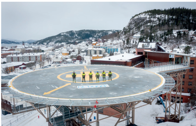
GL-Bygg beskriver seg selv som en allsidig problemløser. Byggingen av den nye helikopterplattformen ved Sykehuset Namsos var noe helt nytt for Overhalla-entreprenøren. Foto: Kommunikasjonshuset Trio Media
