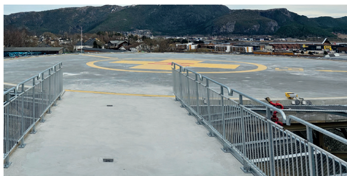
Selve landingsplassen består av Con-Form-elementer med påstøp. Foto: GL-Bygg
