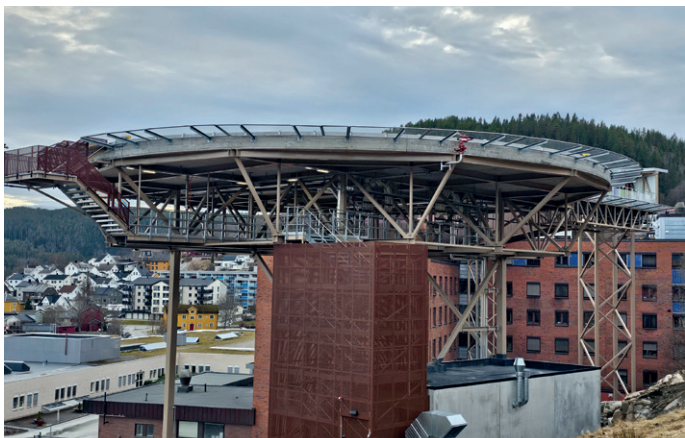
Prosjektet vil blant annet gjøre det mulig å ta imot de nye redningshelikoptrene SAR Queen, som er vesentlig tyngre og kraftigere enn forgjengeren Sea King. Foto: GL-Bygg
