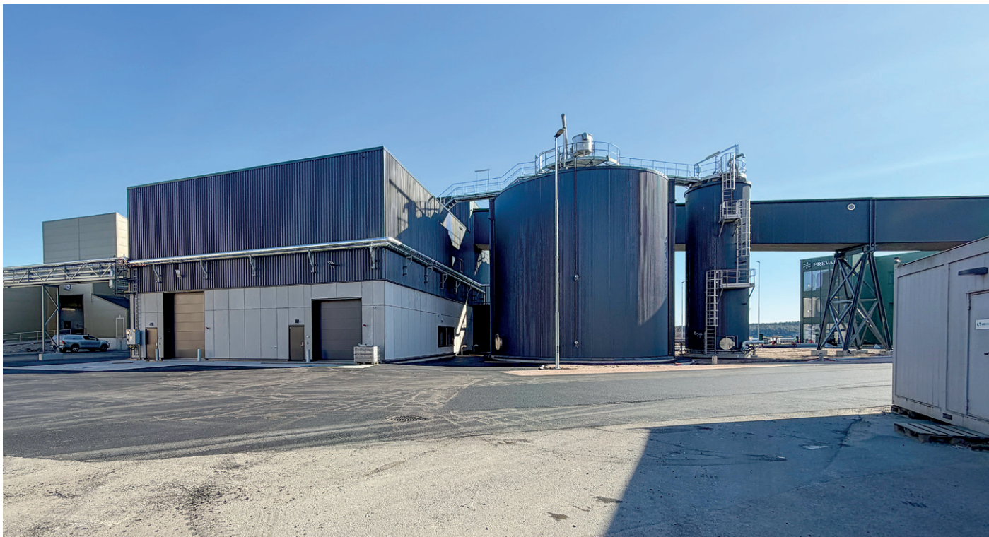
Her ser vi slambehandlingsanlegget og to råtnetanker for biogassproduksjon.
