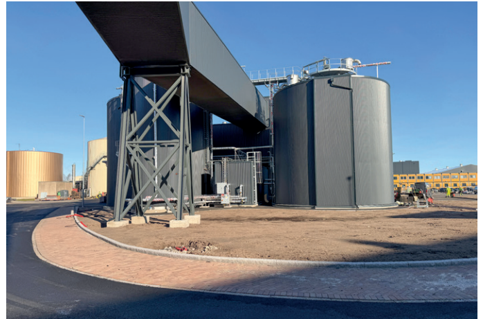
Det er bygget en rørbro som knytter sammen de to anleggene.
