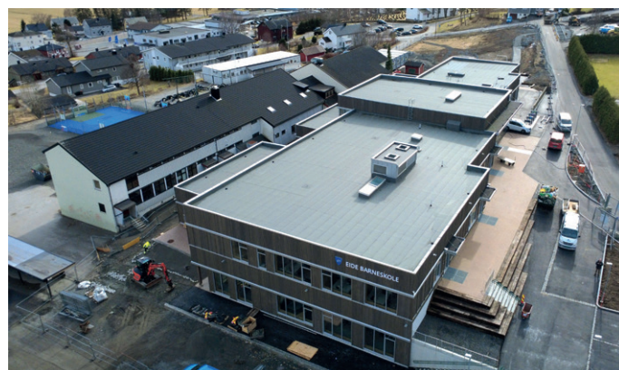
Eide nye barneskole sett fra øst.
