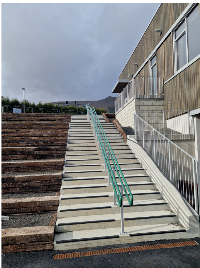
Trapp på vestsiden av bygget.
