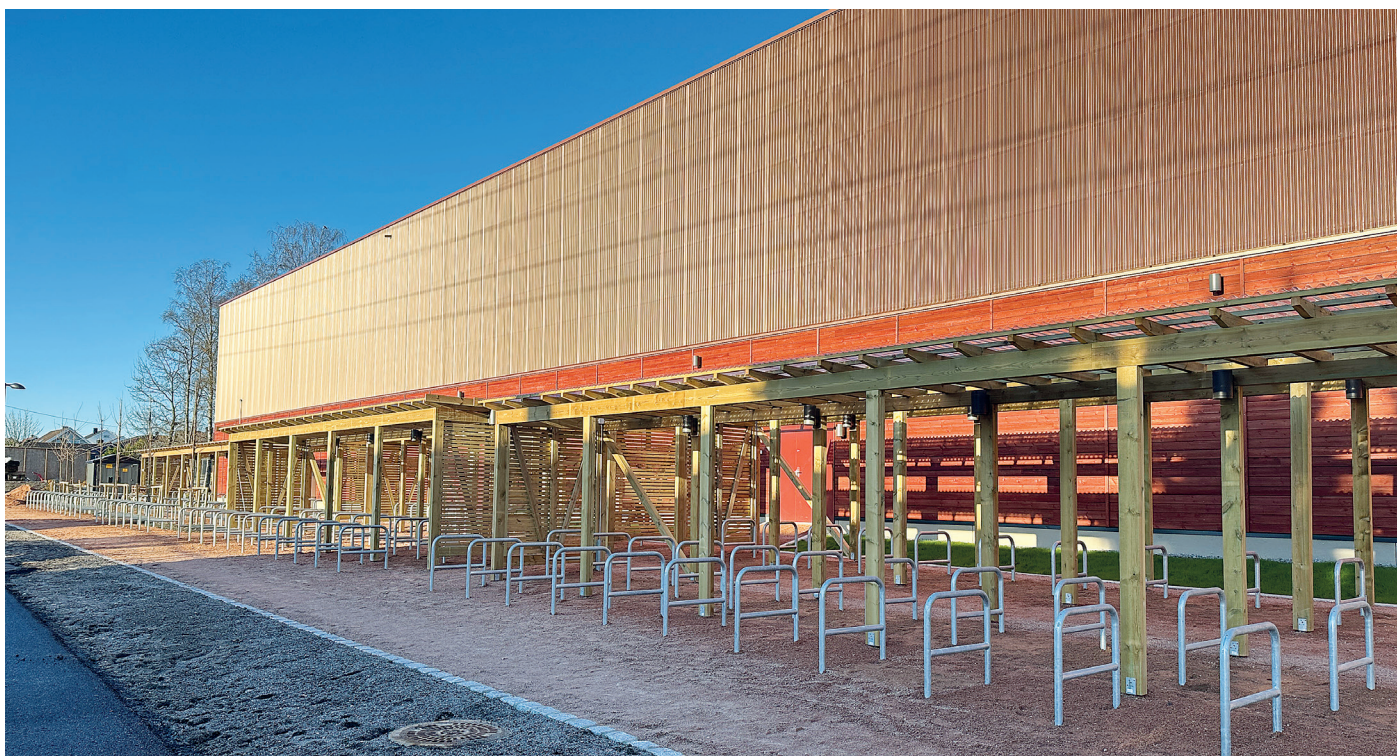
Ved siden av hallen har man laget en stor sykkelparkering.
