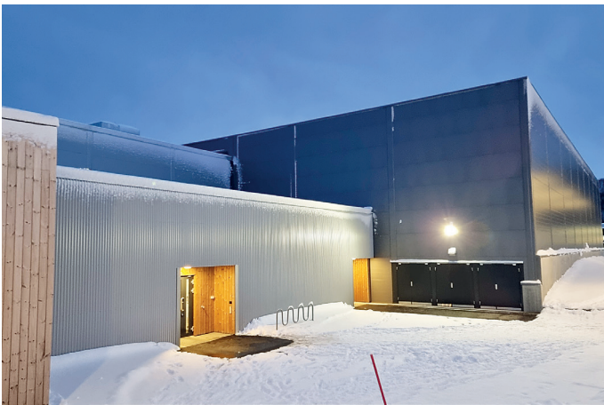
Det nye bygget til rundt 200 millioner kroner er satt opp i en totalentreprise av ArealBygg.
