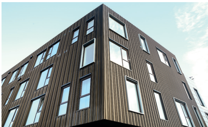
A-blokka i den nye bydelen Skudeløken i Førde er kommet opp og tatt i bruk med leiligheter og hotellrom. På gateplan blir kontorer.
