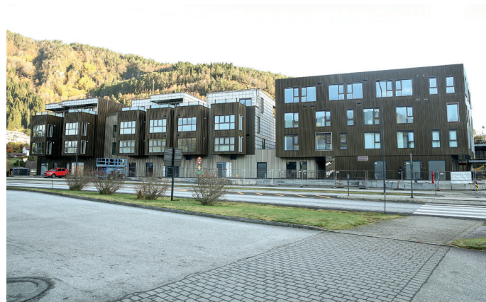
Skudeløken blokk A sett fra gateplan mot vest. Hotelldelen til høyre, leilighetsdelen til venstre, og næringsdelen på gateplan.
