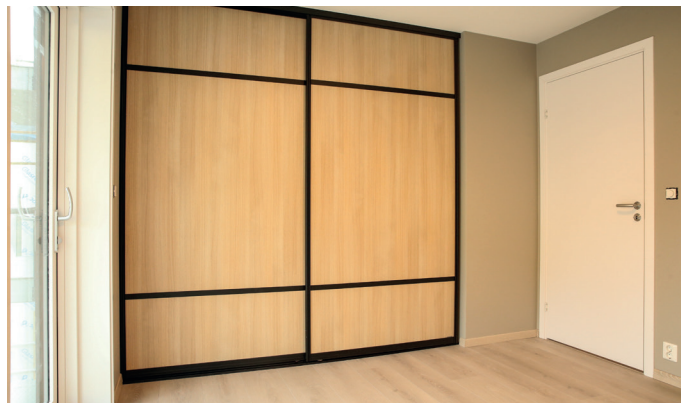
Fra et soverom med utgang til terrasse mot øst. Vi ser her er skyvedørs-garderobe, laminat på gulv og sparklet og malt gips på vegger og i tak.
