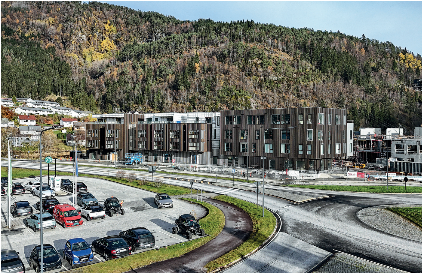
Skudeløken blokk A sett fra fronten mot sørvest. Vi ser bærekonstruksjoner i prefabrikkert betong og stål i B-blokka reiser seg til høyre.
