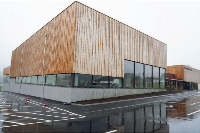
Fasaden rundt svømmehallen og bygdehuset er kledd med varmebehandlet trepanel.
