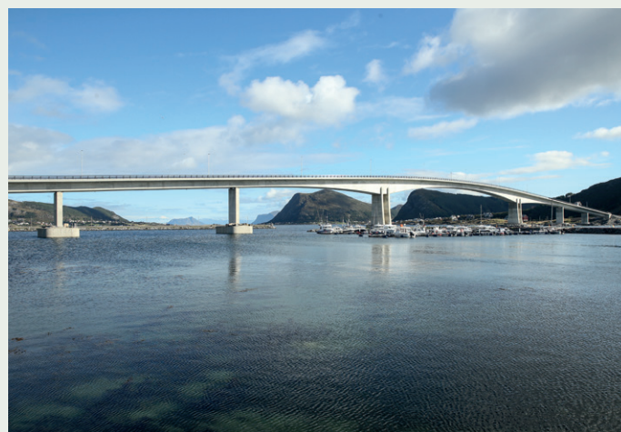
Vi ser her hvordan de to brupilarene til venstre er forankret ned i sjøen mens de til høyre står på fyllinger.
