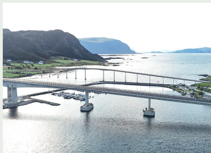
Bildet viser nye Nerlandsøybrua nærmest og den langt spinklere gamle brua bak. Den gamle blir nå revet.
