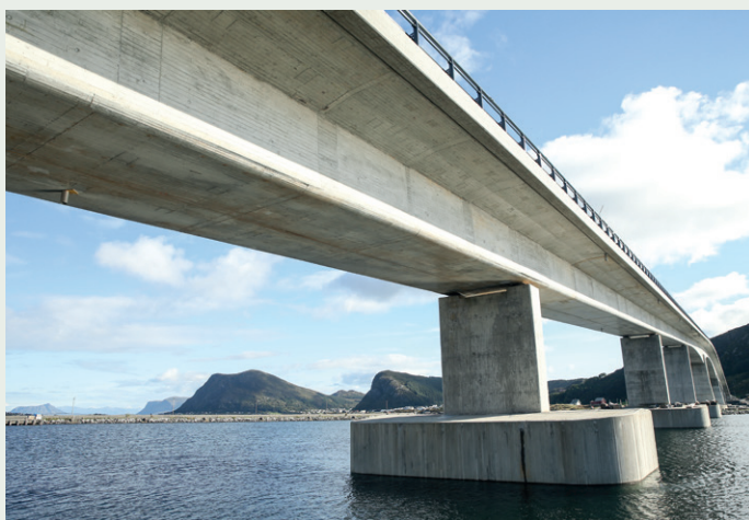
Brupilarene nærmest lgesund er fundamentert på fyllinger i sjøen.
