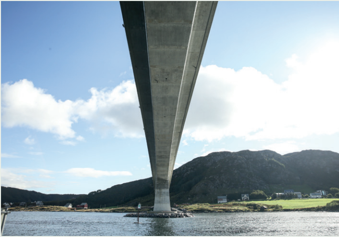
Nerlandsøybrua sett fra undersiden mot bygda Igesund på Bergsøya. Det har gått med 11.000 kubikkmeter ferdigbetong til prosjektet.
