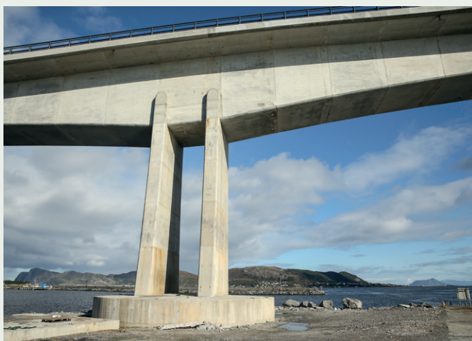
Brupilaren midt på brua er fundamentert på en fylling i sjøen i tilknytning til småbåthavna i Kvalsund.
