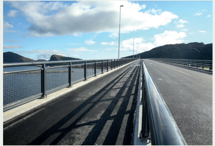
Gang- og sykkelvei er adskilt med rekkverk fra bilveien med to kjørebane. Arvid Gjerde er underentreprenør for rekkverk.
