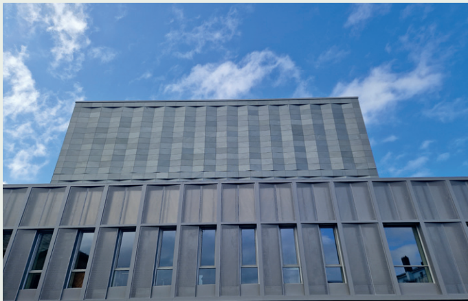
Nybygg sett fra øst.
