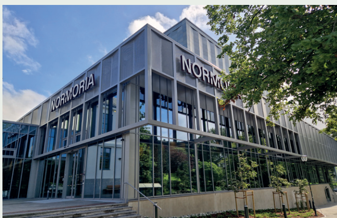
Nybygg sett fra nord-øst.
