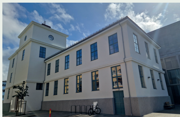
Det gamle rehabiliterte skolebygget mot nord.
