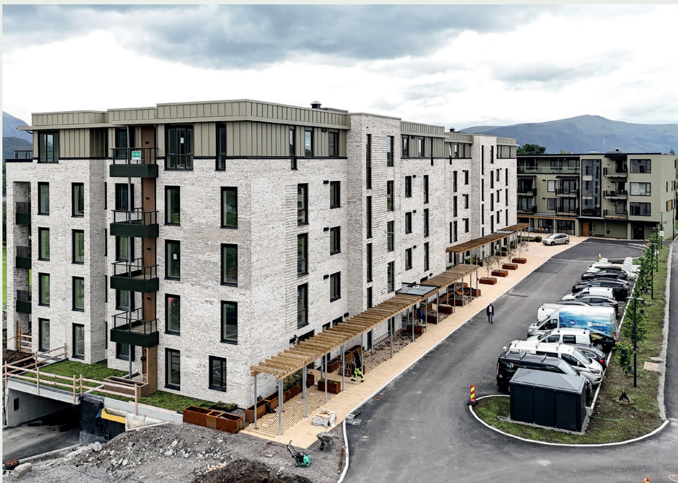
Daaetunet sett fra øst med blokk C nærmest. Totalt er det 75 leiligheter i boligkomplekset som står ferdig nå.
