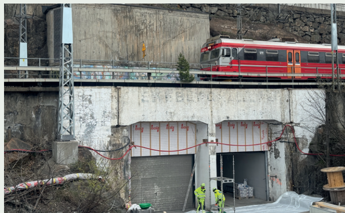
Foto: Varden Entreprenør
