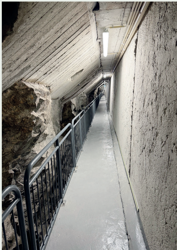
Brann- og rømningsvei mellom de to fjellhallene.
