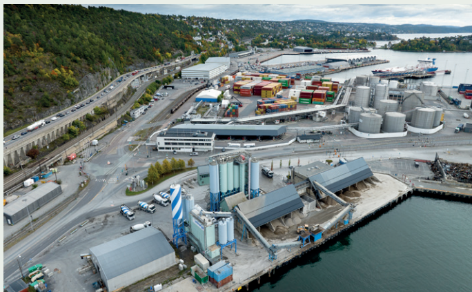
Ekeberghallene har innslaget på Sjørsøya. Foto: Varden Entreprenør
