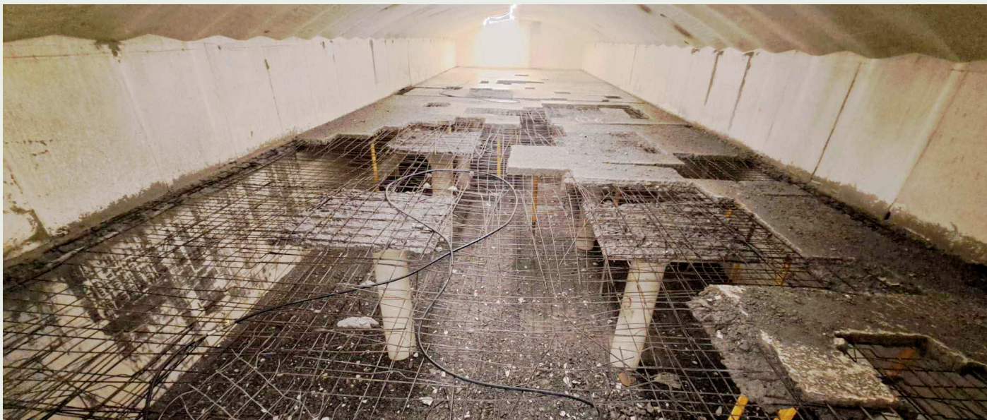
All skadet betong i hallene ble meislet ut før ny betong ble lagt.
