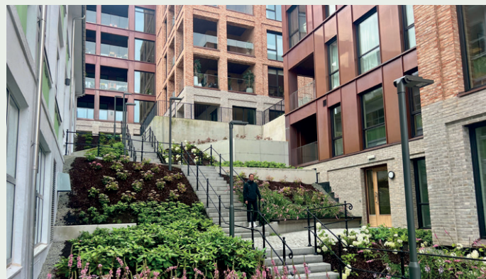
Totalentreprenørs prosjektleder Caroline Austbø Fjetland i et trappeløp i komplekset.
