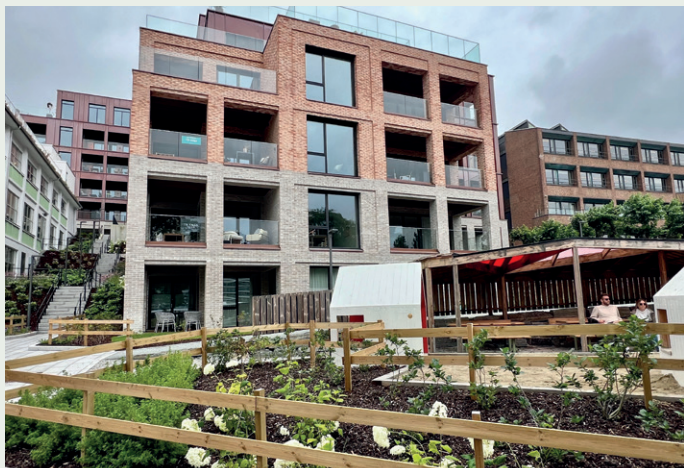
De fleste har overbygd balkong, enkelte balkonger er også innglasset.
