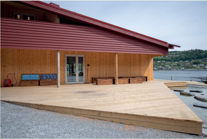
Platting på byggets sørside.
