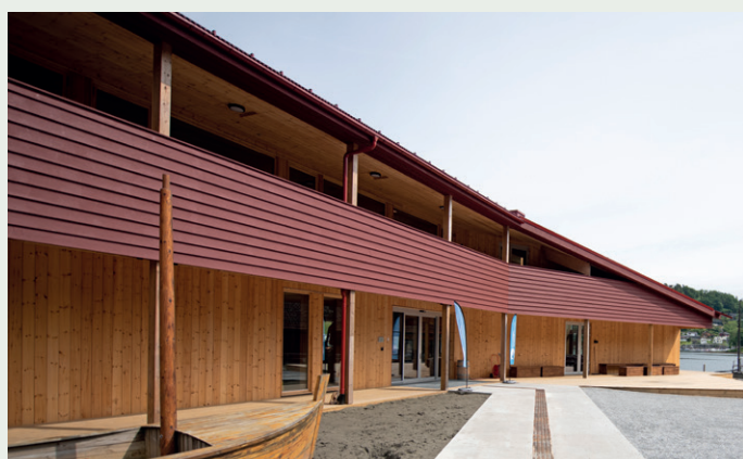
Trasé av betong med ledelinje mot hovedinngang.
