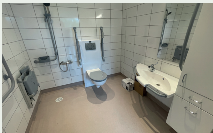
Toalettene ble prefabrikert og montert som ferdige seksjoner.
