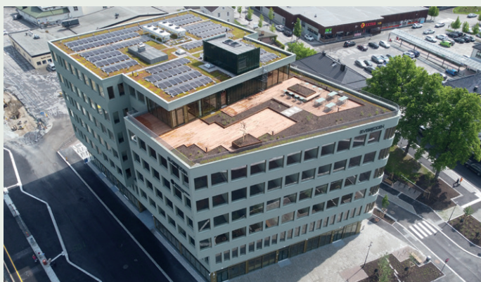
Elvebredden er et nytt kontorbygg i Kongsvinger sentrum, rett ved siden av togstasjonen.
