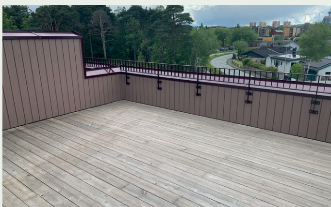
Rekkehusene på tre etasjer har stor takterrasse.
