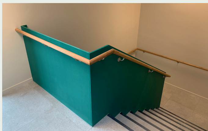
Grønt rekkverk i valchromat i oppgangen. Flislagte trapper.
