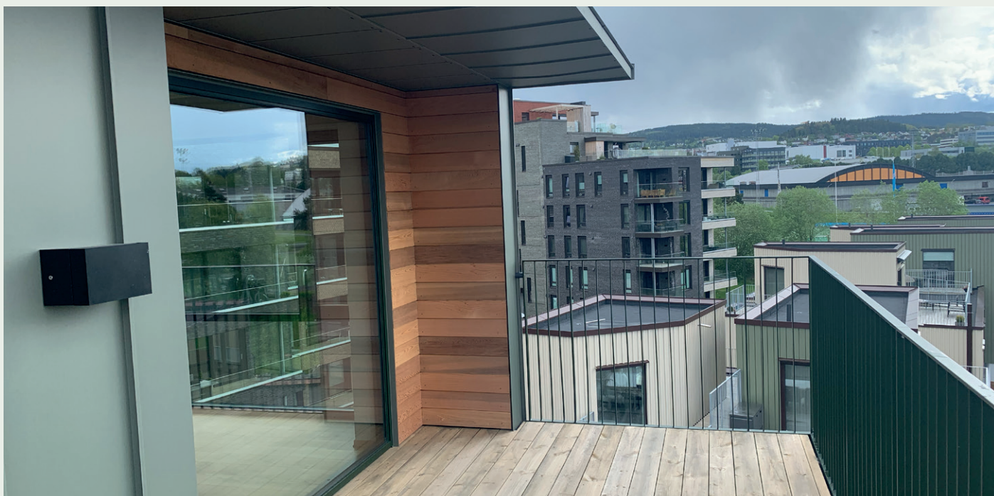
Sedertre i kombinasjon med sinkplater.
