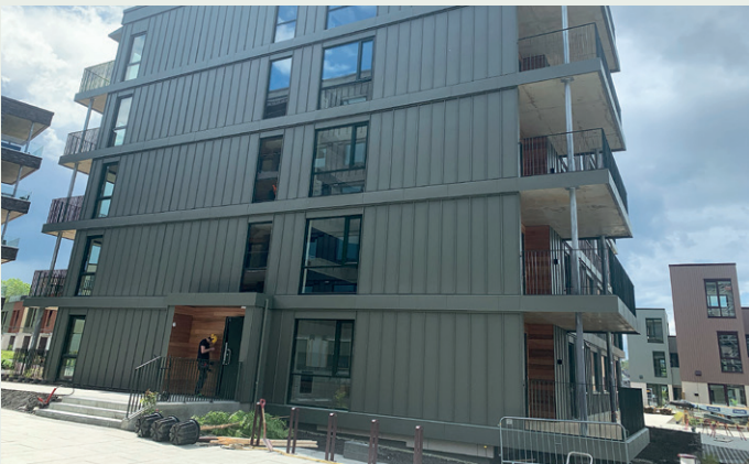
To av de fire leilighetsbyggene får sinkplater i grønn farge.
