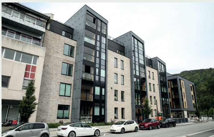
Byggetrinn 1 til venstre, byggetrinn 2 til høyre, sett fra gateplan i Langebruvegen.
