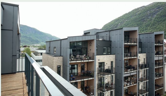
Langebruvegen er satt opp i to byggetrinn med to adskilte blokker. Her ser vi byggetrinn 1 fra toppen av byggetrinn 2.
