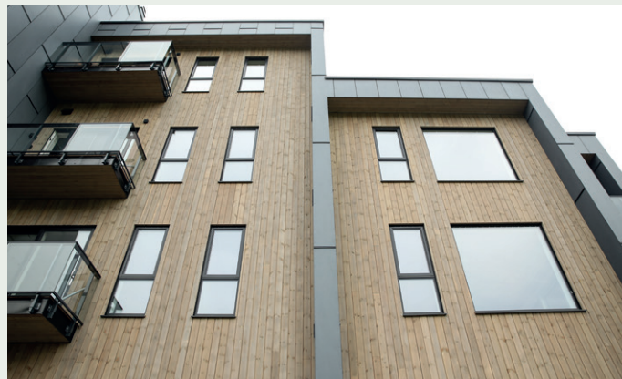
Byggetrinn 2 har lys brunn brannimpregnert malmfuru fasadekledning, kombinert med sorte Swisspearl fasadeplater.
