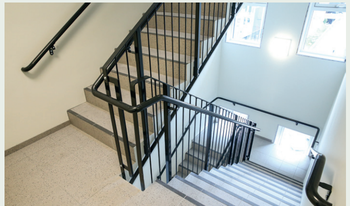
Trappeoppgangene er flislagt. Sjaktene er stedstøpt betong med malte overflater.
