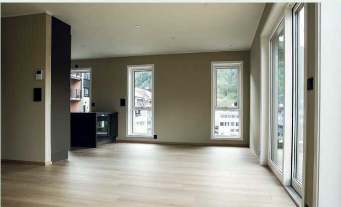
Gulv i leilighetene har Pergo laminat. Vegger og tak er sparklet og malt gips med listefrie overganger.
