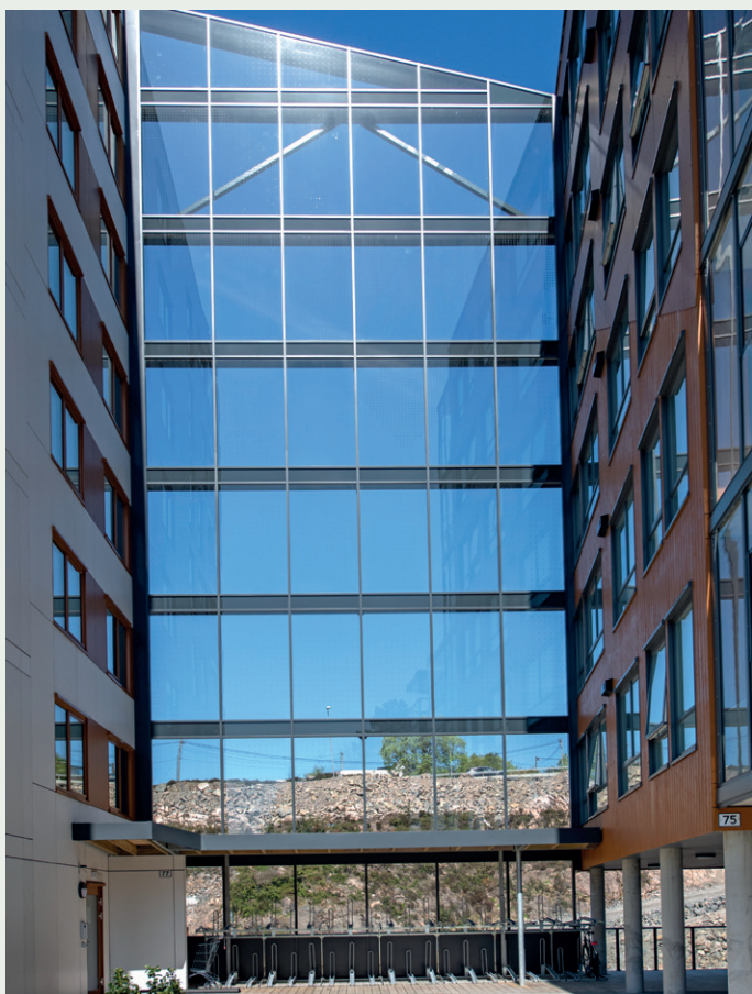
Det er oppført glassvegg som støyskjerm mellom Ørnen og det nærmeste bygget i byggetrinn 1.
