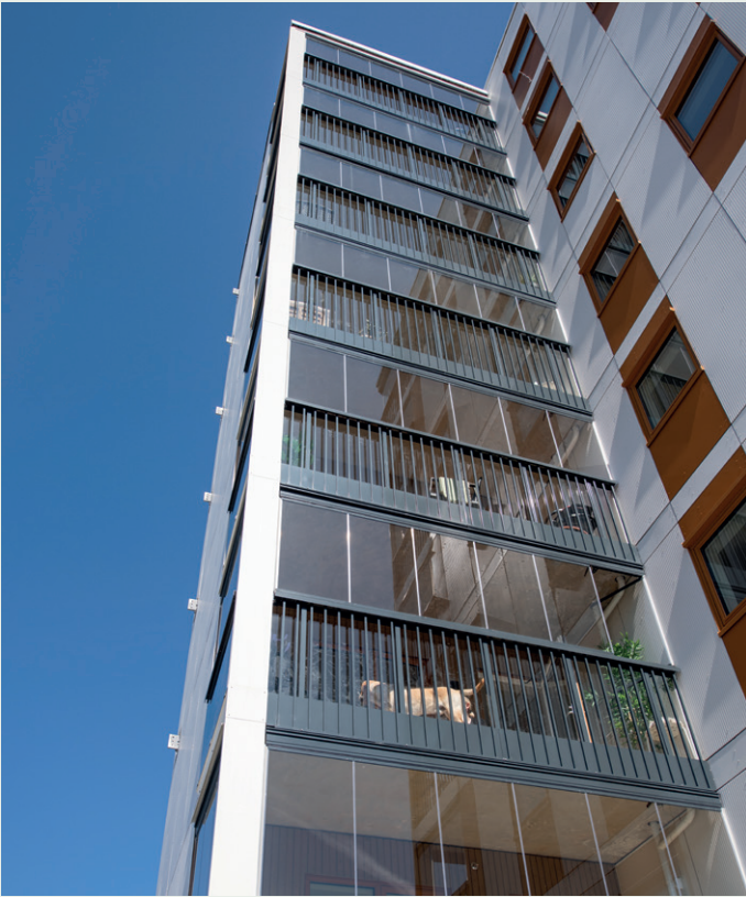
Innglassete terrasser på leiligheter nærmest brua på Skjergardsvegen.
