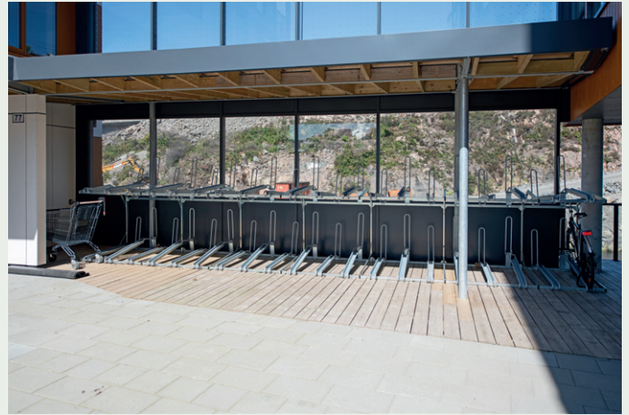
Overbygd sykkelparkering ved byggets hovedinngang.
