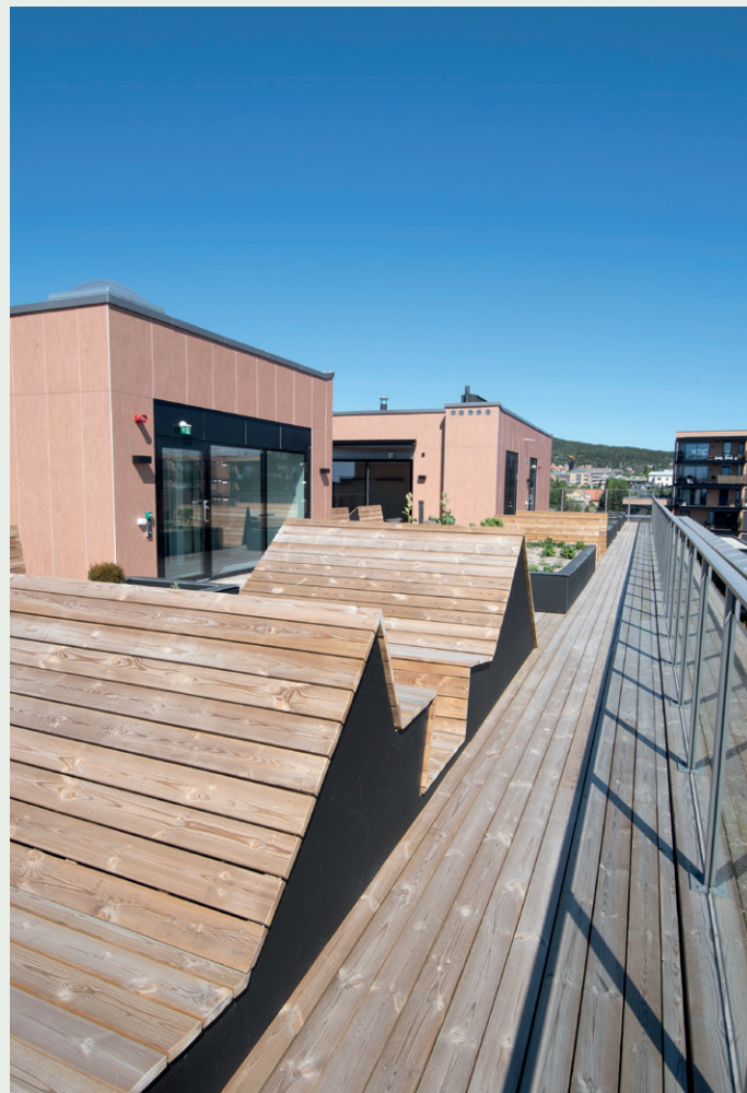
Prosjektet har flere felles takterrasser, samt takstuer som beboerne kan benytte seg av.
