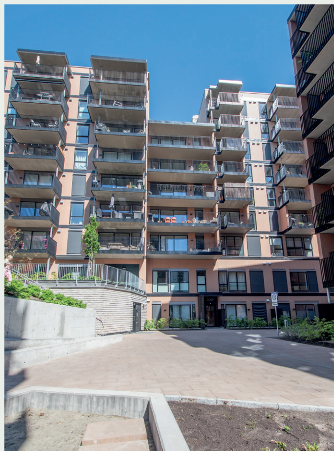
Fasadene inn mot gårdsplassen er kledd i spesialutviklede steinplater som ser ut som tre.
