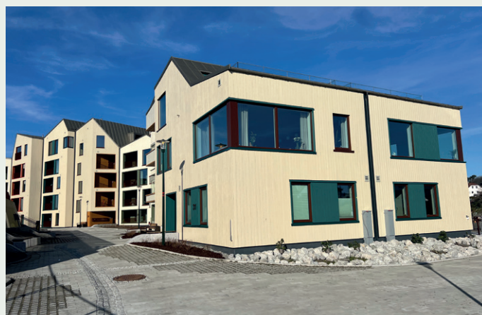
Bygget ytterst mot øst omtales som rekkehuset. Leilighetene går over to etasjer, og har takterrasser.
