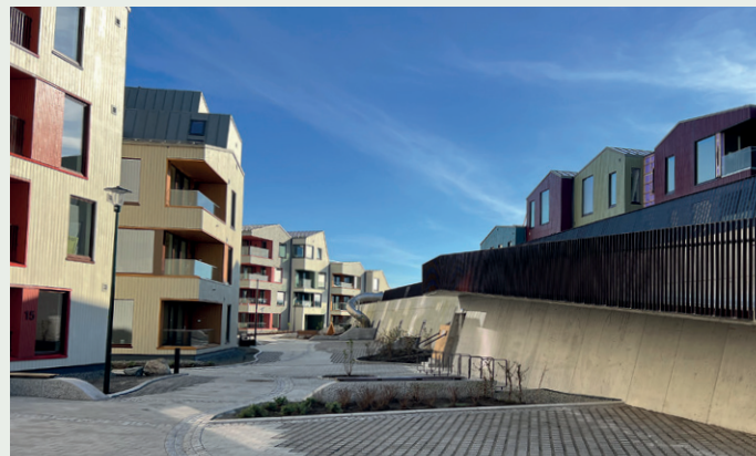
Arbeidet pågår fortsatt over parkeringsgarasjen og bygget bak denne.
