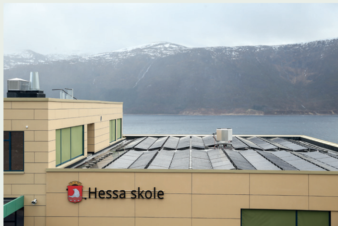
Det 6.500 kvadratmeter store bygget skal etter planen være selvforsynt med energi, noe solcellene på taket bidrar til.
