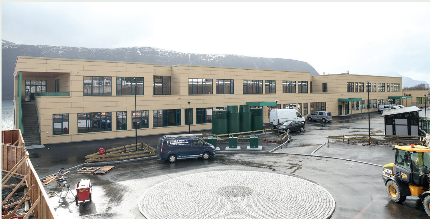
Fra inngangspartiet på nordsiden av skolen. Her er arbeidet med uteområdet fortsatt i gang. Nærmiljøanlegget skal bygges utenfor venstre bildekant der gamle bygg fortsatt står.
