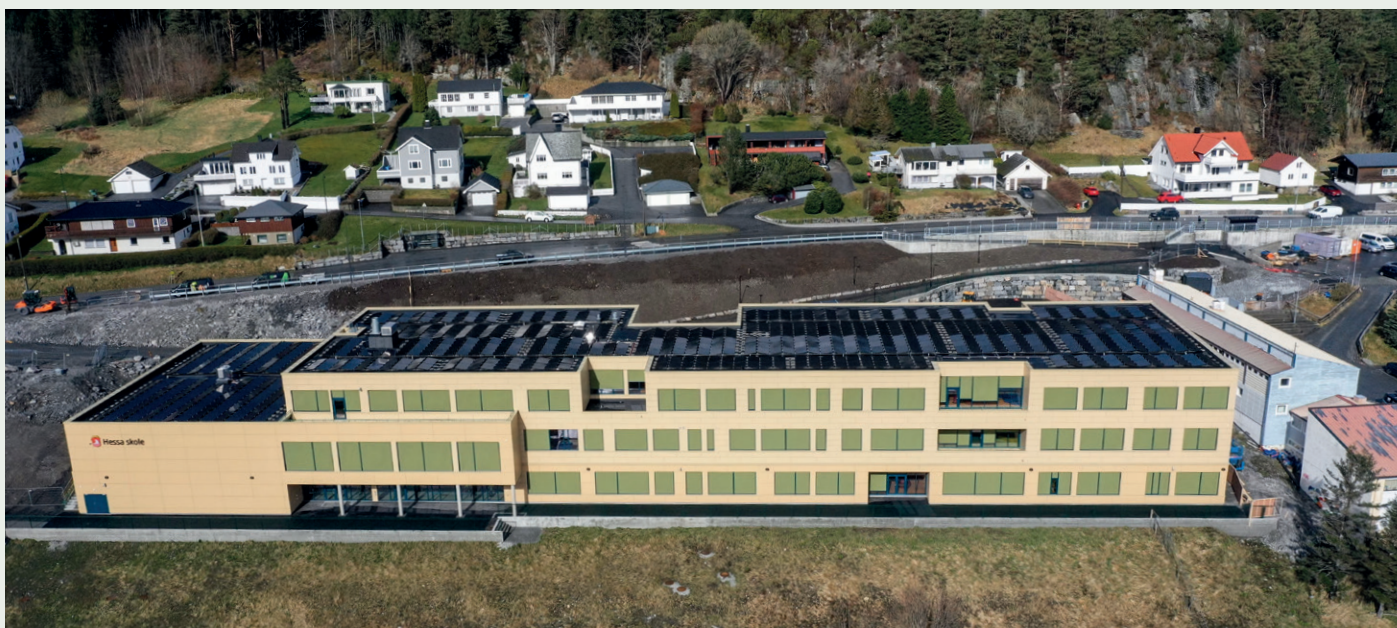
Hessa skole sett frå sør. Vi ser hvordan hele taket er dekket av solcellepanel. Solcellekraftverket er beregnet å produsere 260.000 kilowattimer i året.
