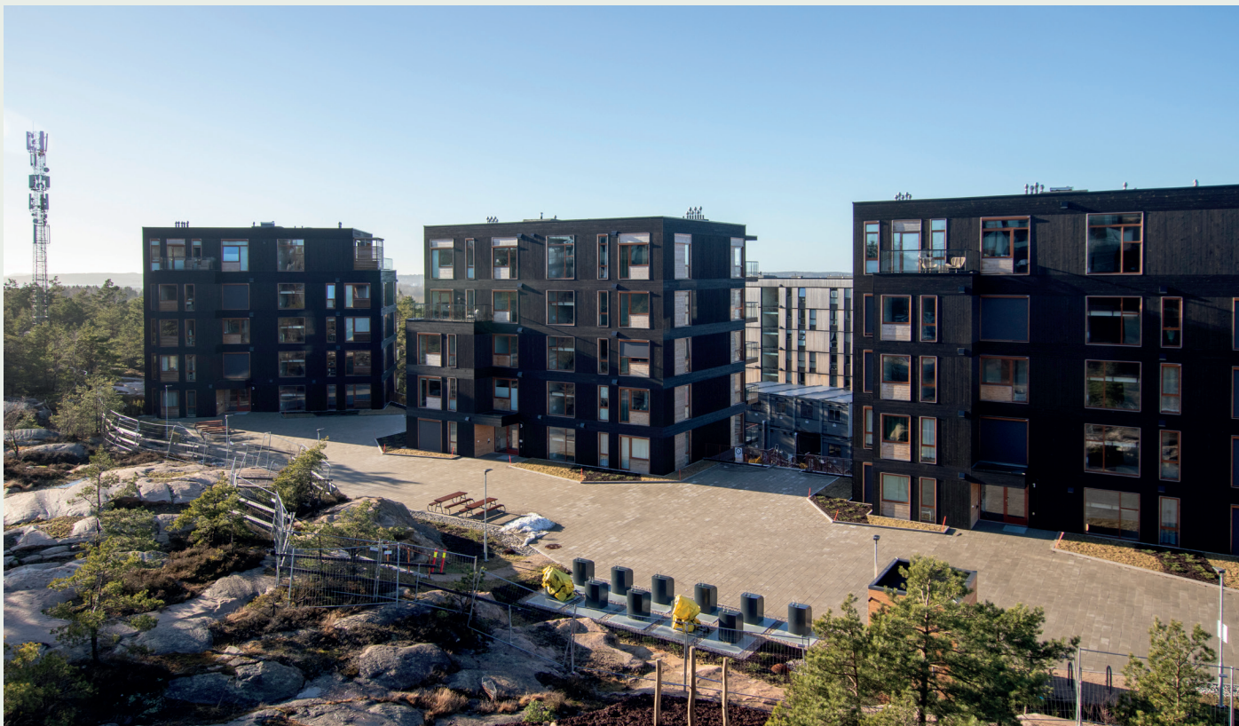
Dette er OBOS tredje byggetrinn på Begbyåsen. Mellom de nye blokkene skimtes forrige byggetrinn.
