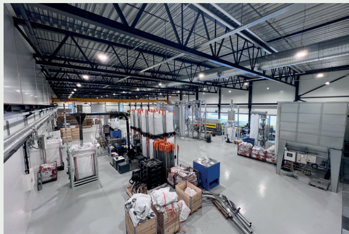
Det er etablert et kraftig gulv i bygget, som har 150 millimeter dobbeltarmert betong, for å kunne tåle store maskiner og tung vekt.
