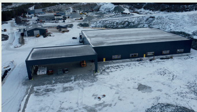
På slutten av 2024 ble Hallingplasts nye resirkuleringsfabrikk i Ål satt i drift.
