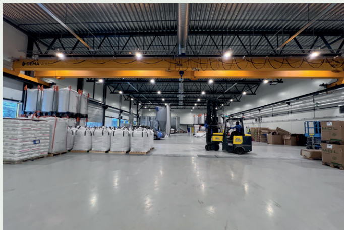
Det er to produksjonshaller i bygget, med en brannskillevegg imellom. Hallene er hver på 26 ganger 72 meter.
