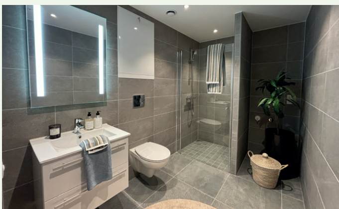
Alle bad i de nye blokkene er prefabrikkerte kabiner.
