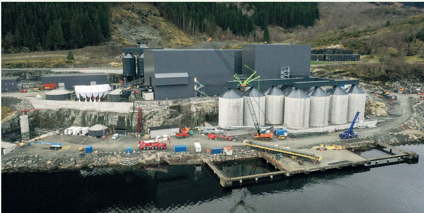
Prosessanlegget kan deles inn i fem bygg, der et av byggene er multifunksjonsbygg med kontrollrom, laboratorium, kontorer, kjøkken og garderober, et bygg inneholder verksted med lager, og tre av byggene er prosess- eller fabrikkbygg der mineralproduksjonen finner sted.
