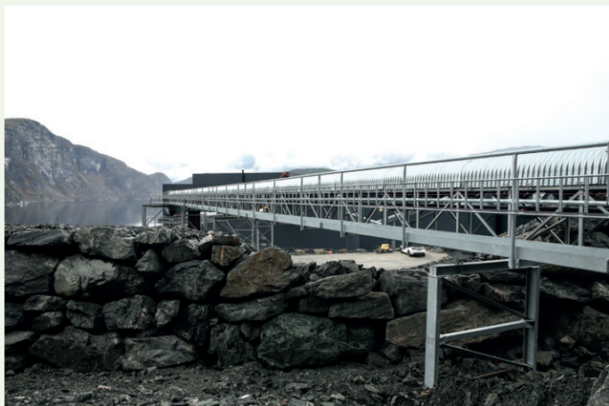
Transportbåndet skal frakte titanmalmen som kommer ned gjennom sjakten inne i fjellet, ut til prosessanlegget ved fjorden der den blir prosessert til høyverdig rutil og granat.
