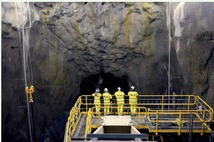
Det er sprengt ut en vertikal sjakt fra toppen av fjellet med dagbruddet ned til tunnelen der malmen blir knust og fraktet videre på transportband til prosessanlegget ved sjøen. Her ser vi arbeidere i sjakten. Foto: Nordic Mining
