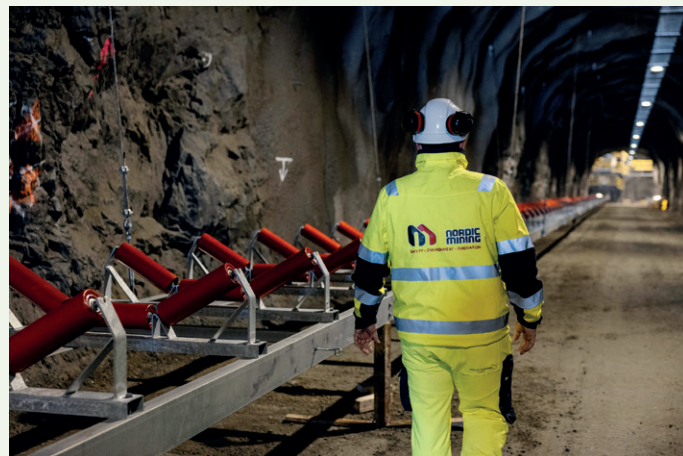
Fra tunnelen inn til den 220 meter vertikale sjakten ned fra dagbruddet som vi ser i enden av tunnelen.
