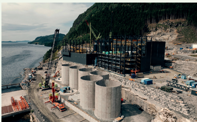
Fra anleggsperioden. Her blir bærende konstruksjoner i stål montert på betongfundament. Foto: Nordic Mining
