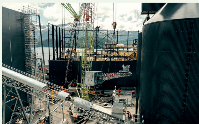
Fra anleggsperioden der prosessanlegget er i ferd med å reise seg ved Førdefjorden. Foto: Nordic Mining
