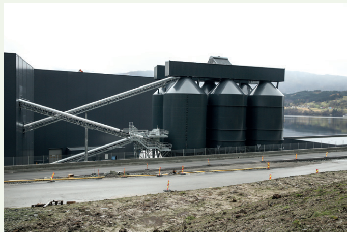
Noen av systemene med transportband og siloer på anlegget til Nordic Mining på Engebø.
