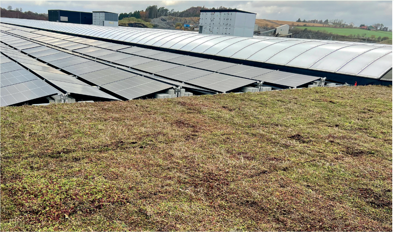
Taket over verkstedhallen med solceller og sedum.
