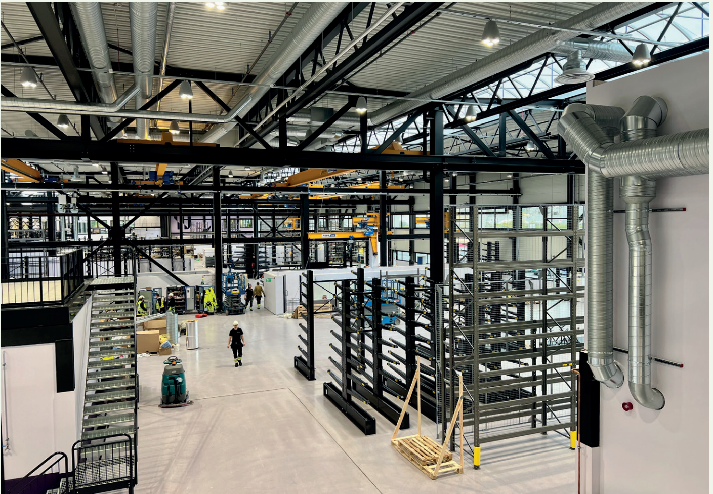
Gulvet i hallen er støpt på avrettet grunn.
