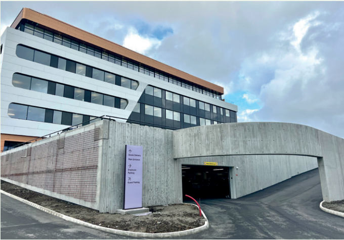
Allerede ved innkjørselen til parkeringshallen dukker en av de gjenkjennelige buene opp, denne i betong.
