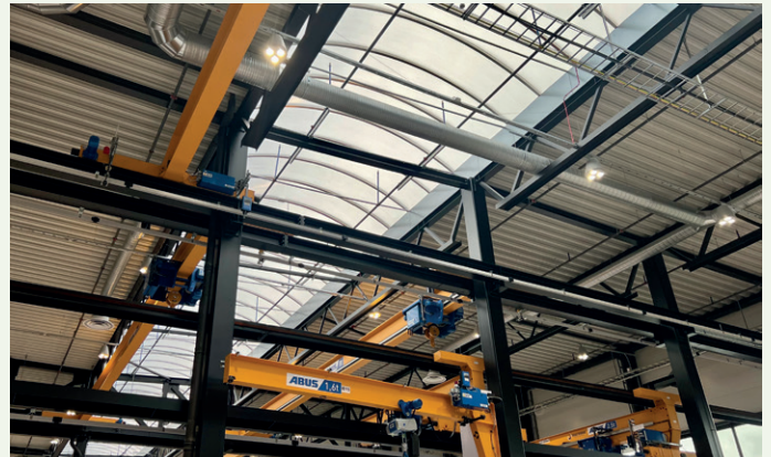
Takvindue gir lys inn i verkstedhallen.
