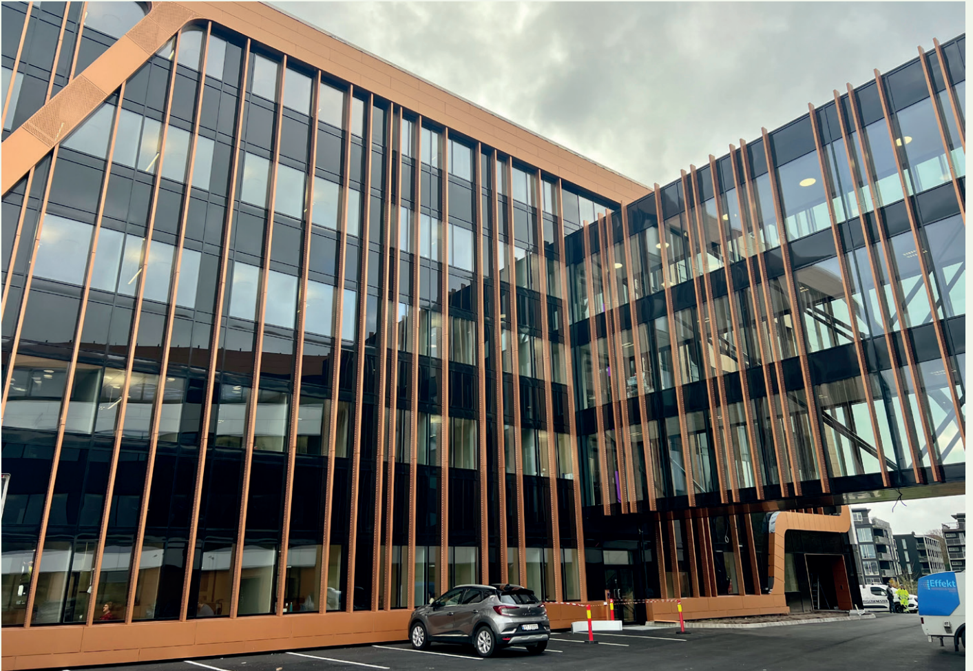
Kontorbygget er forbundet med hovedbygget og verkstedhallen med gangbruer.
