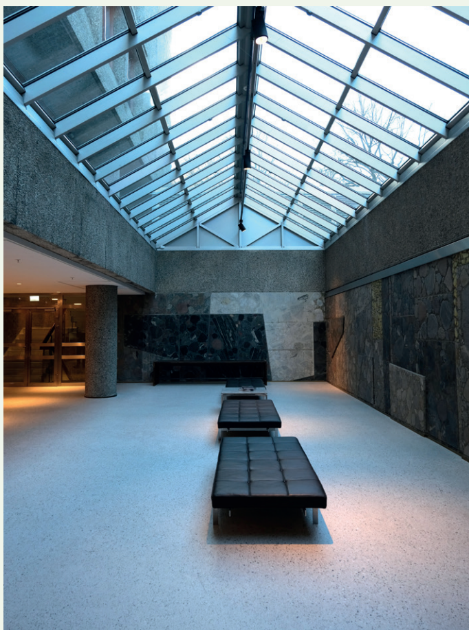
Det er lagt et nytt helstøpt gulv i første etasje.
