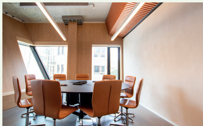
Møterommene får naturlig ventilasjon som settes i gang når man går inn.
