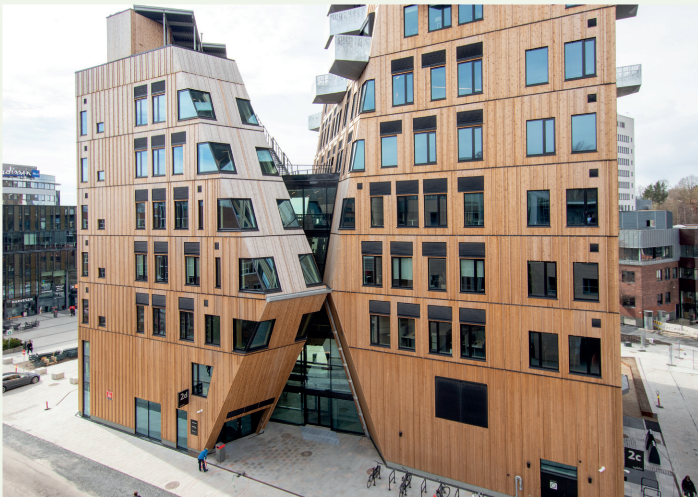
De første etasjene i Vertikal Nydalen består av næring og kontorer i de syv første etasjene, og så boliger videre oppover til 18. etasje.
