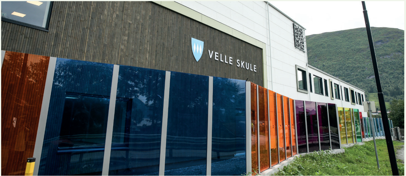
Materialene på fasaden er Swisspearl Cembrit-plater, Moelven malmfuru trekledning og NorDan-vinduer.
