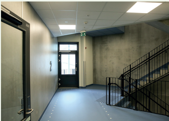
I trappeoppgangene er det eksponert betong på vegger, vinyl gulvbelegg og systemhimling.
