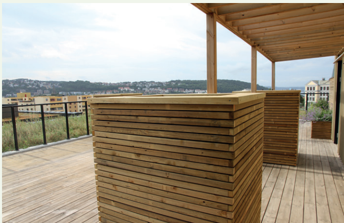
En stor takterrasse tilhørende en av de største leilighetene med utsikt over byen.
