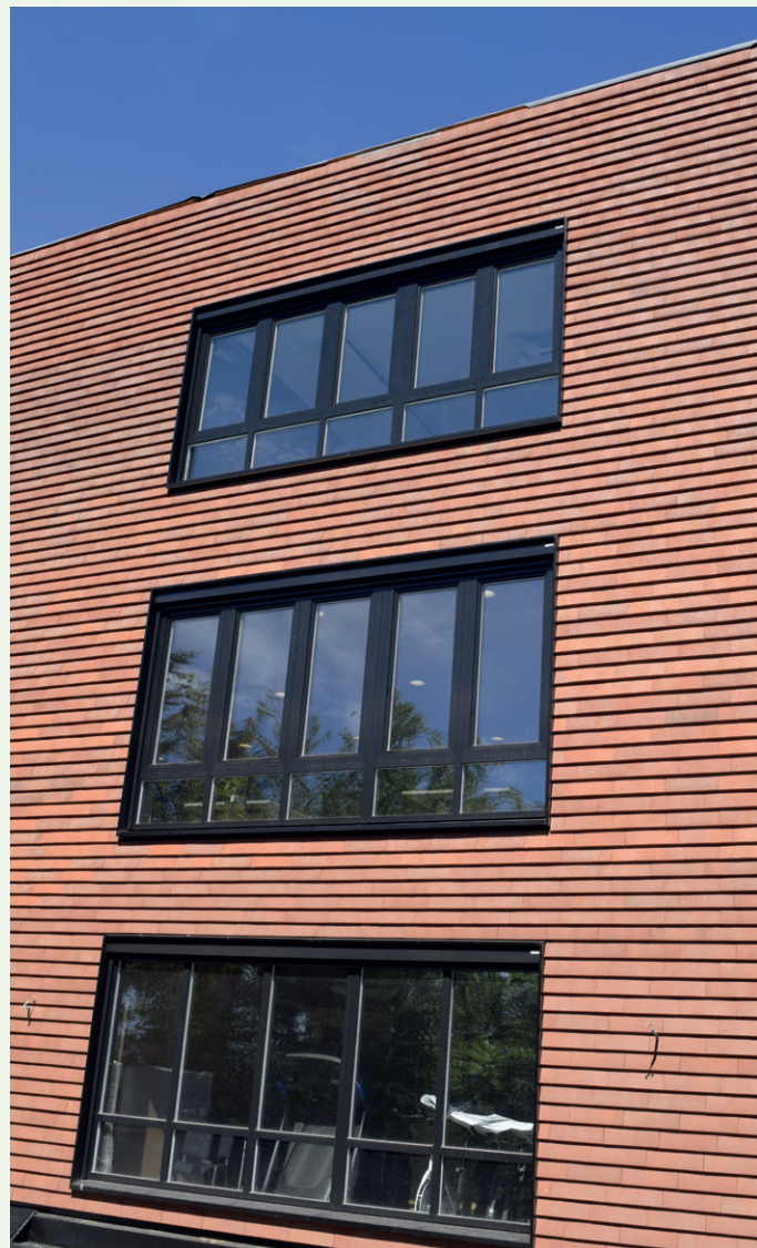
Fra fasaden mot sør.
