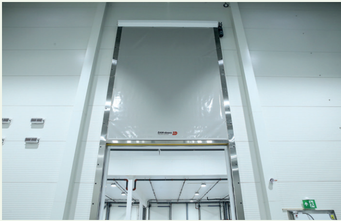
DAN-doors har levert disse hurtigportene for frys, portene skal være 60-70 prosent effektive for å holde på kulden.
