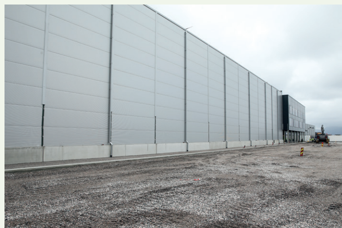
Delen av bygget med fryse- og kjølelager og tørrvarelager er 12.300 kvadratmeter. Det er et klassisk næringsbygg med brystningselementer som ringmur, stålkonstruksjon og påmonterte sandwichpaneler.
