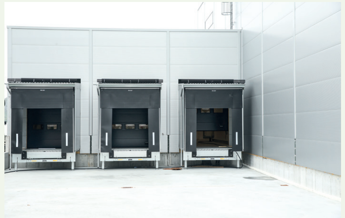
Disse tre portene i den sørvestlige enden av bygget sikrer god logistikk for bilfrakt.
