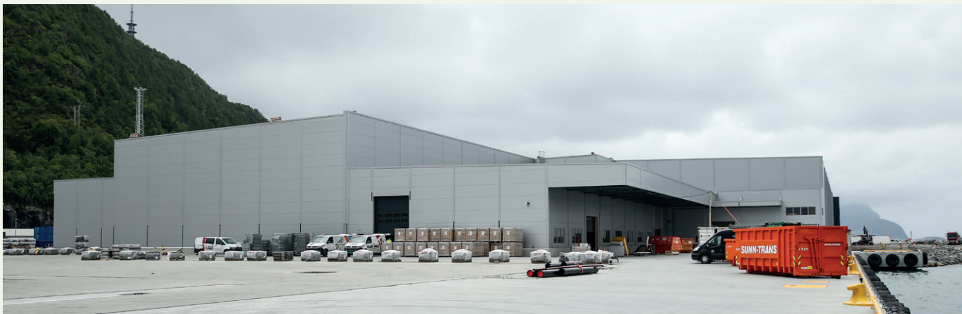
Fra kaia er det porter inn i bygget mot øst, der trucker kan kjøre lasten inn til lagring.
