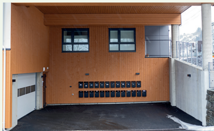
Postkasser og nedkjøring til parkeringsanlegg.
