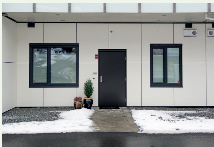
Plateledning ved inngang til leilighet på bakkeplan.
