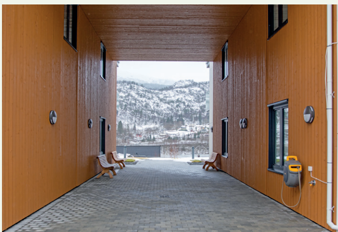
Bygget er delt av en portal, her sett fra øst.
