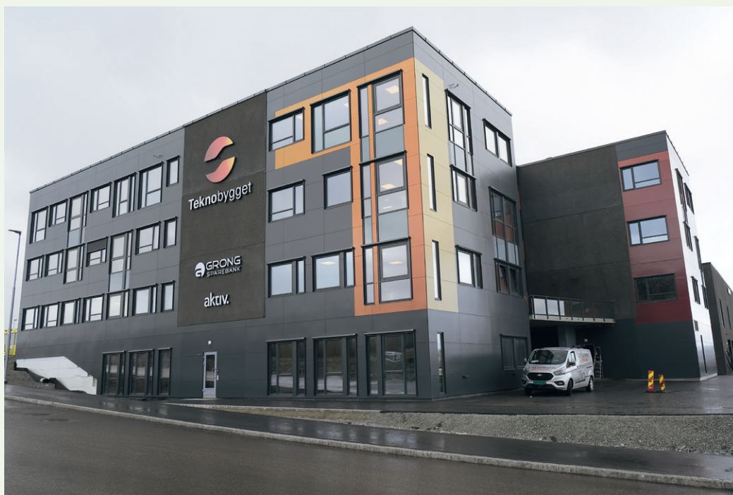
Teknobygget sett fra siden som vender mot riksveien.
