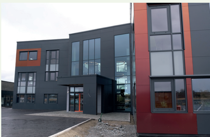
Fasaden vender inn mot byggtorget som er under utvikling.
