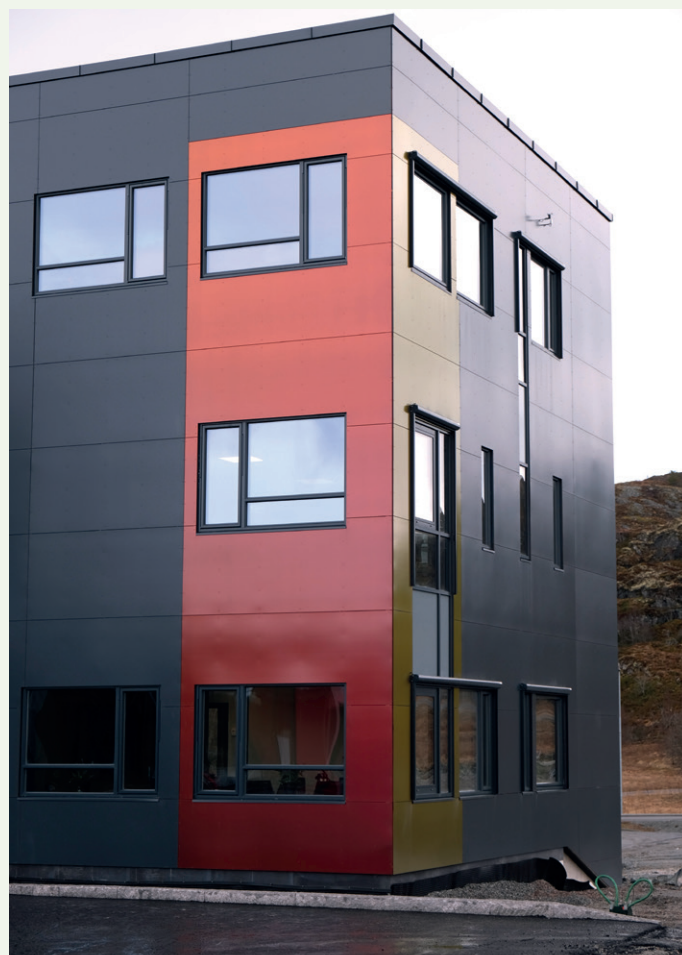
Kameleon-panelet endrer farge med vinkelen på lysinnfallet. Når du beveger deg, skifter fargen.
