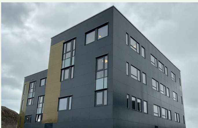
Baksiden av Teknobygget med sokkeletasjen.
